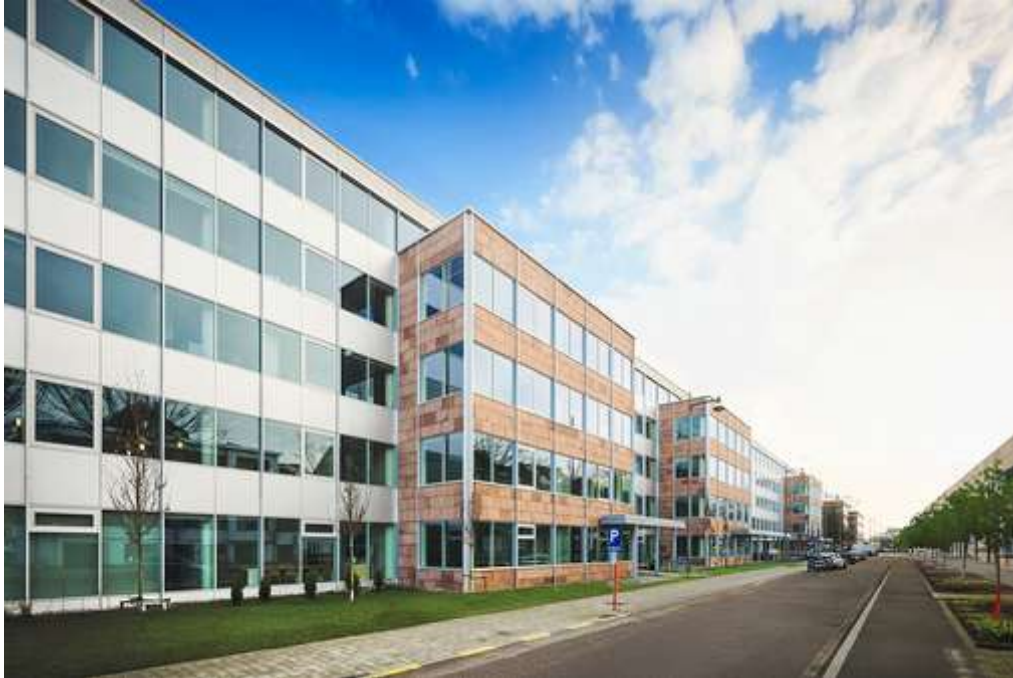
► Office building Stationsstraat 110 - Mechelen/Malines (BE)
